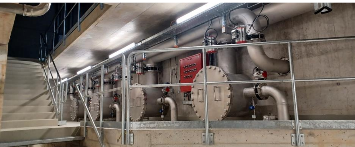
GAK-Filterzellen mit Mannlöcher
