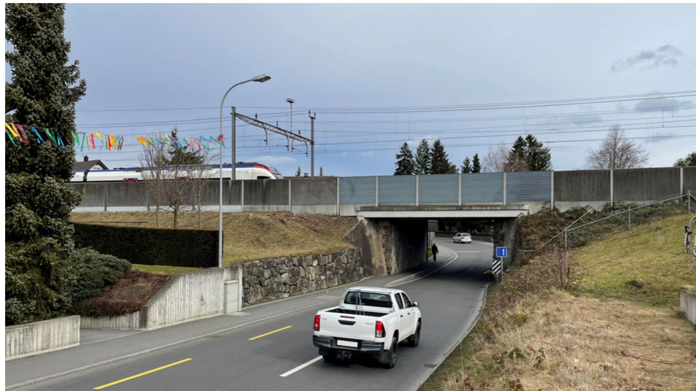
Die Bahnunterführung an der Zürcherstrasse heute.
