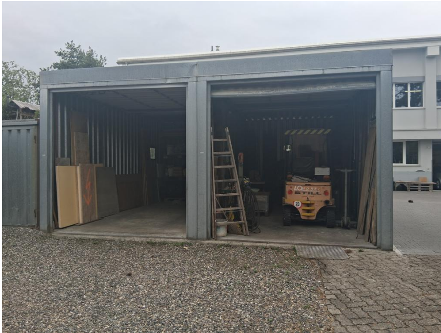
Nr. 6+7 Container Material Lager
