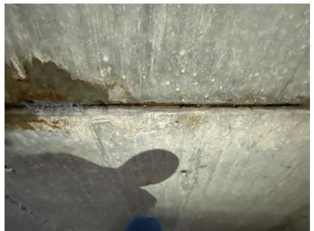
Abb. 3: Undichte Deckenfuge
