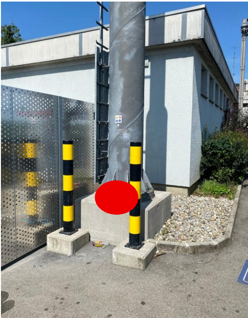
Abbildung 2: Sicht auf den Standort des Funkmastes (rot), Prona AG 06.08.2025.
