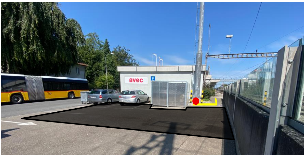
Abbildung 3: Sicht nach Nord-Osten auf den Projektperimeter: Funkmast (rot), Kabeltrasse (gelb) und Installationsplatz (schwarz), Prona AG 06.08.2025.
